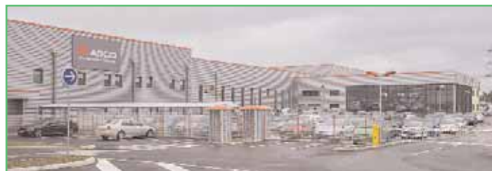
Новая площадка завода Massey Ferguson в г. Бове (Франция)
