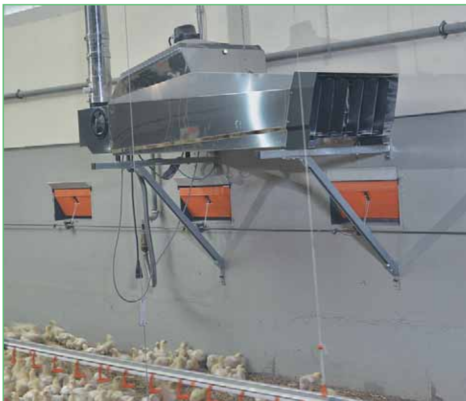
Фото 6. Теплогенератор с отводом продуктов горения Thermorizer
